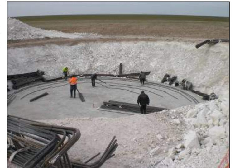
Photo 67 : Exemple de fondations à remettre en état
