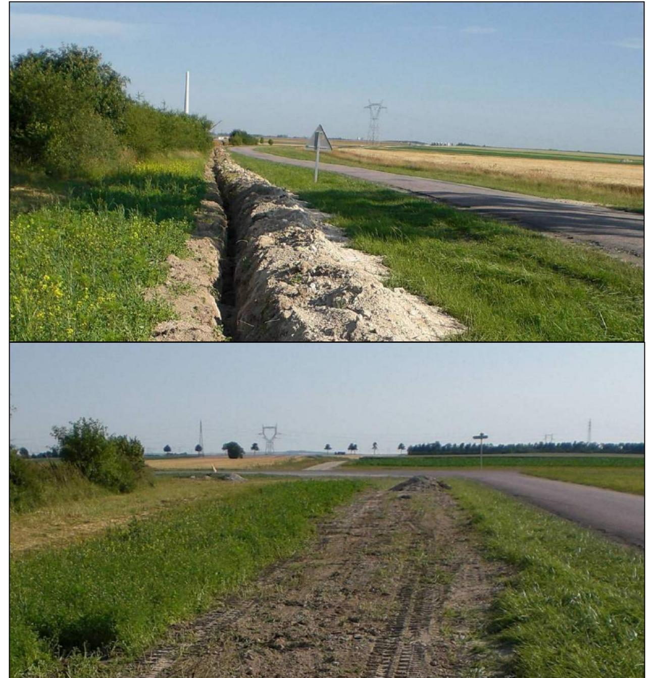
Photo 91 : Rebouchage de tranchée après passage des câbles électriques (Source : BE JC)
